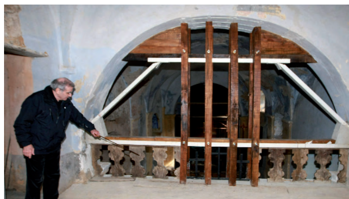
Ouvrage très particulier, car le renforcement de la voûte ne s'appuie pas sur la voûte du dessous. On le voit sur la photo, le renforcement est réalisé par un ingénieux système d'entretoises et de boulons. L'alliage du fer et du bois. Les madriers verticaux sont libres, ils ne touchent pas la terre.
